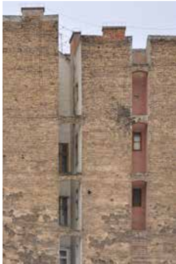
Lichtschächte zur Belüftung von Bädern und Küchen
