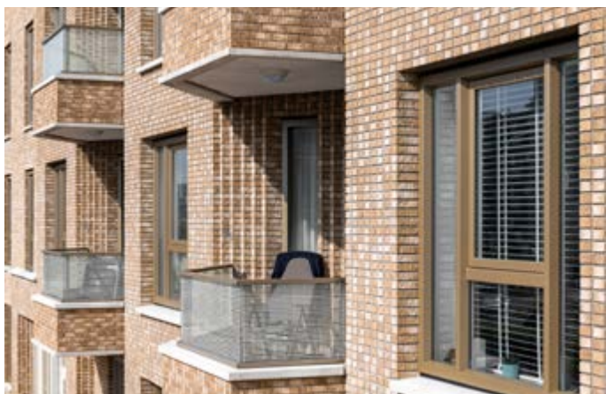
Details van het getrapte metselwerk bij de balkons. Foto's: Sebastian van Damme.
