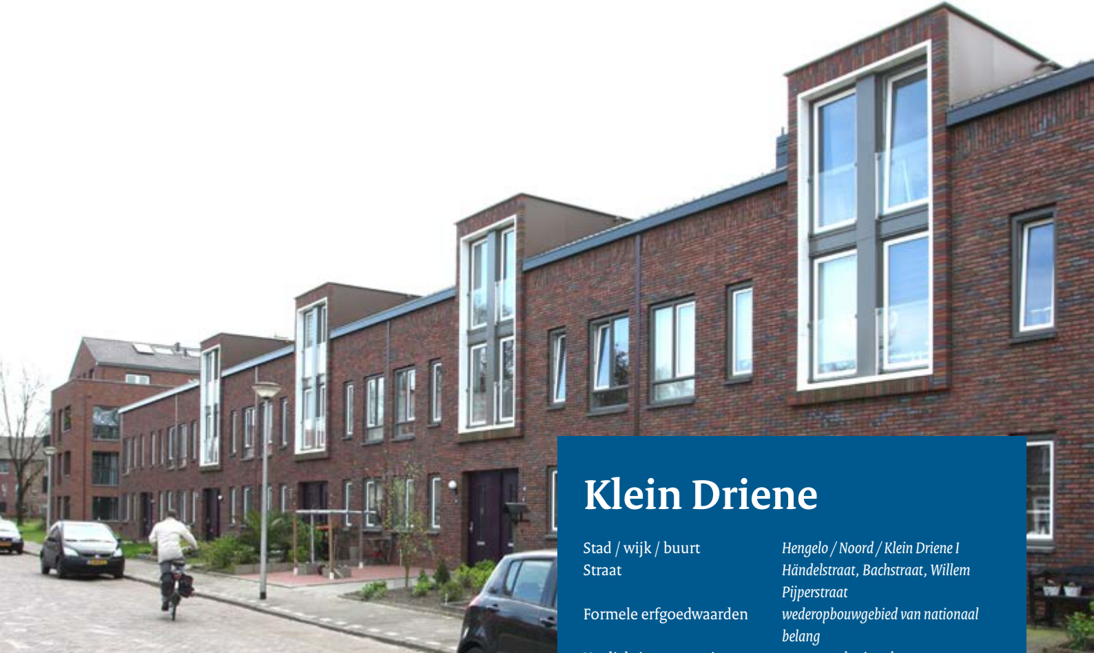
De door de dakrand stekende kaders van de nieuwe eengezinswoningen in de Bachstraat zijn geïnspireerd op de oorspronkelijke architectuur. Foto: WY.architecten.
