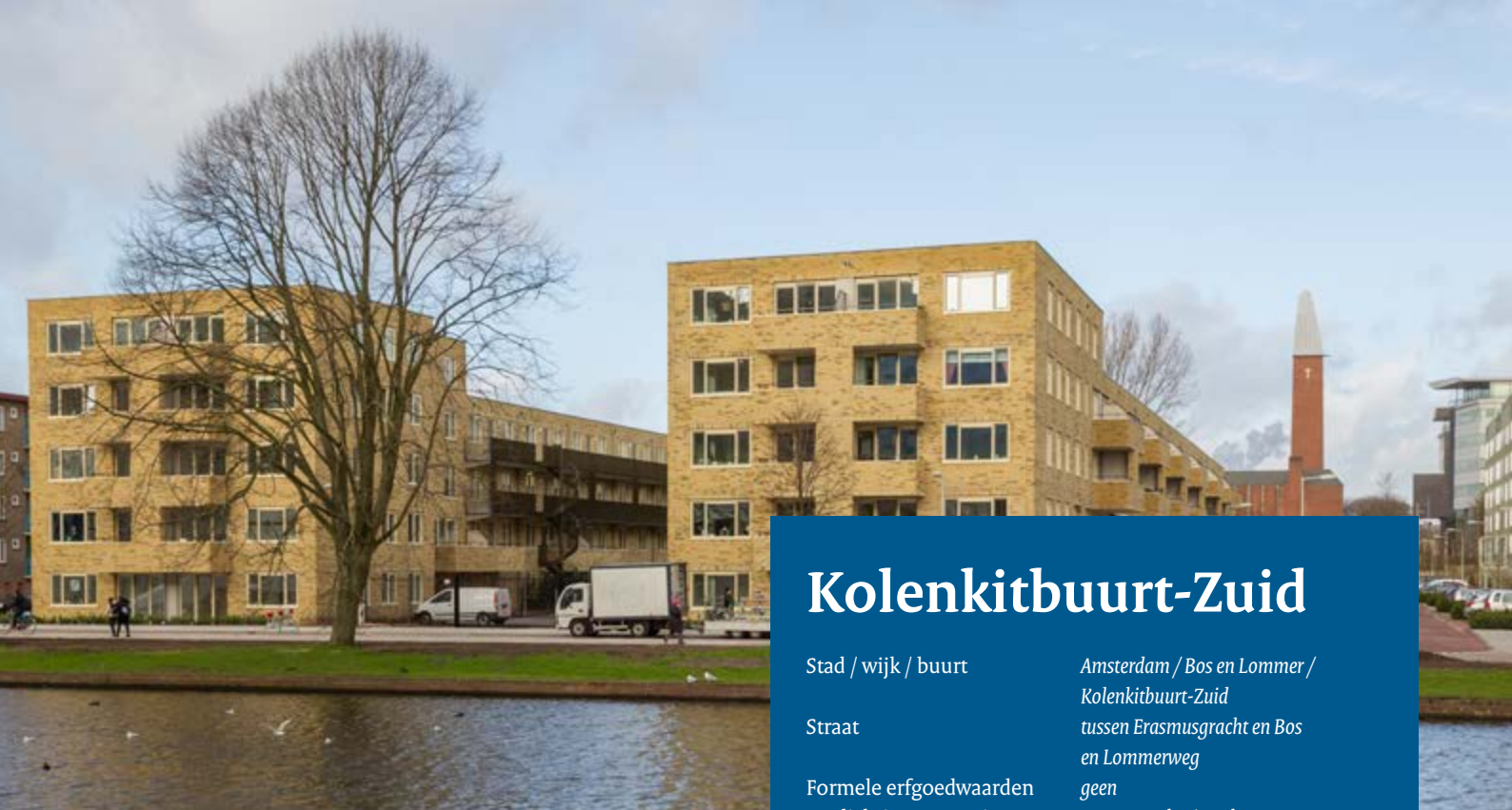
Zicht vanaf de Erasmusgracht op de twee door Quist Wintermans Architecten ontworpen stroken. Op de achtergrond de Kolenkitkerk. Foto: Quist Wintermans Architecten.
