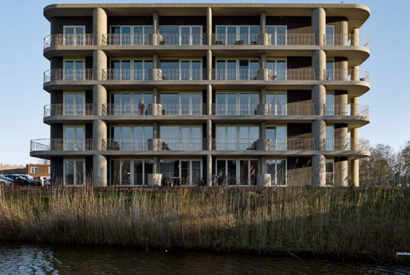
Het Tuinhuis is in hout opgebouwd, met er omheen een zelfdragende balkonstructuur. Foto: Stefan Müller.
