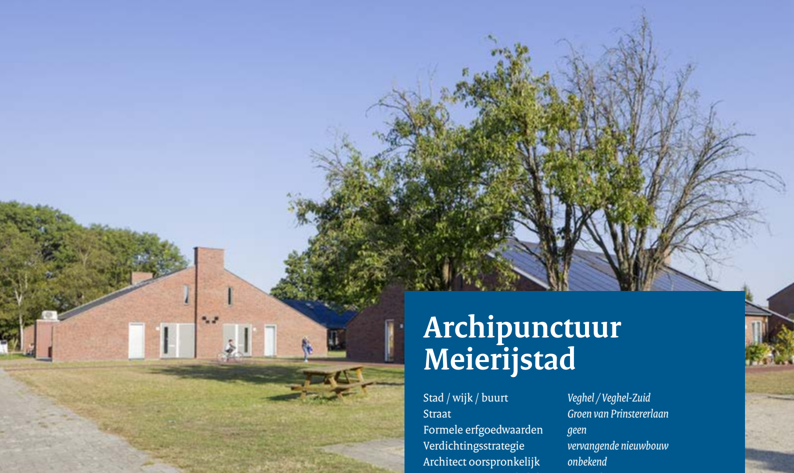
Drie gebouwen met kwadrant- / rug-aan-rugwoningen zijn losjes in het groen geplaatst. Diverse boomgroepen zijn behouden. Foto: Rob van Esch.
