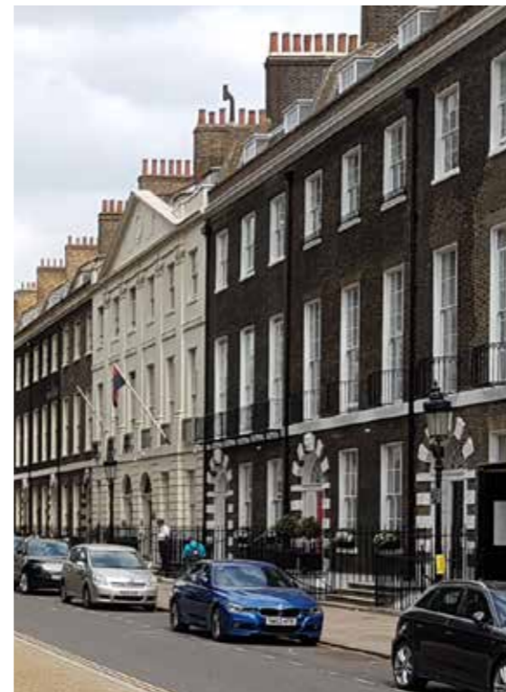
Doorlopende Franse balkons Bedford Square, Londen (anon.)
