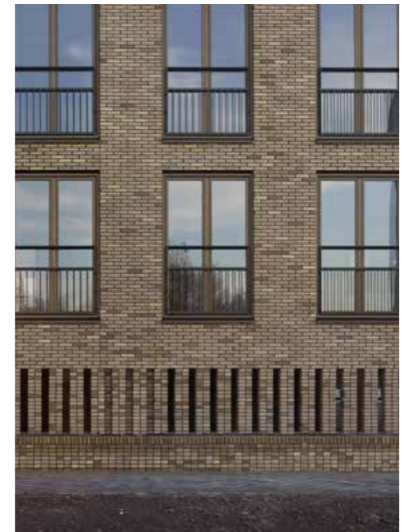
Ventilatie garage Jan Wolkerssingel, Utrecht (Arch. HvdHA)
