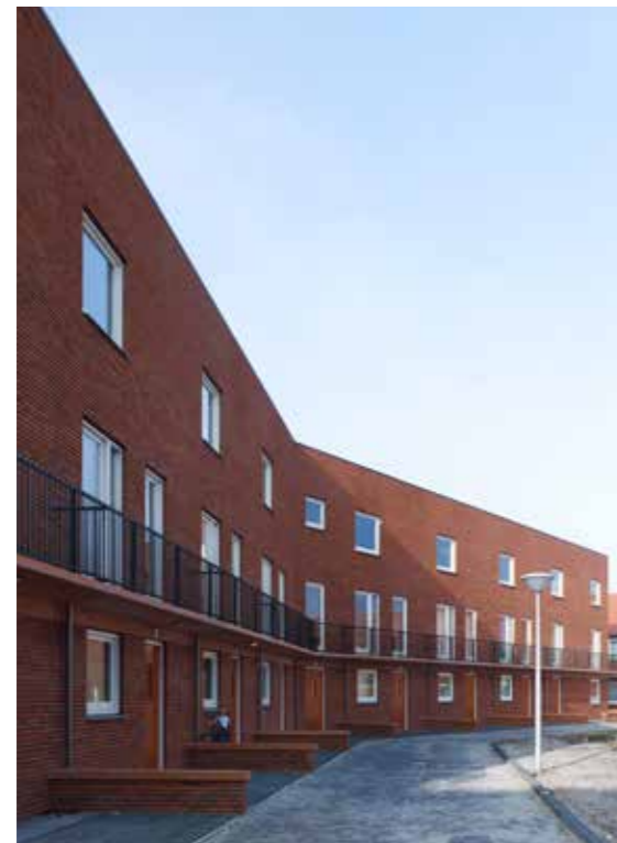
Doorlopende Franse balkons Lakerloopen, Eindhoven (Arch. HvdHA)
