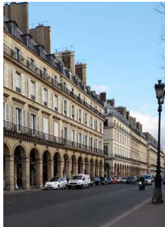
14 Doorlopende stadsbalkons Rue de Rivoli, Parijs (Haussmann)
