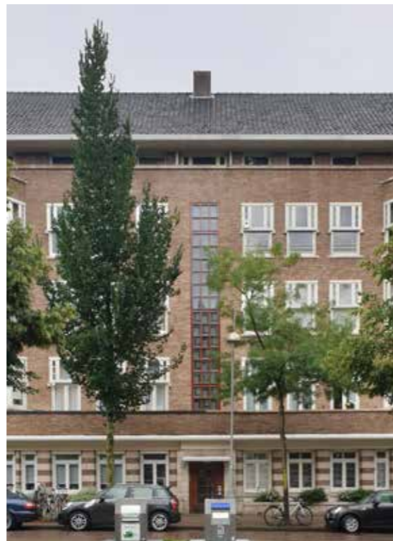
Stadsbalkons Minervalaan, Amsterdam (Arch. Blaauw)
