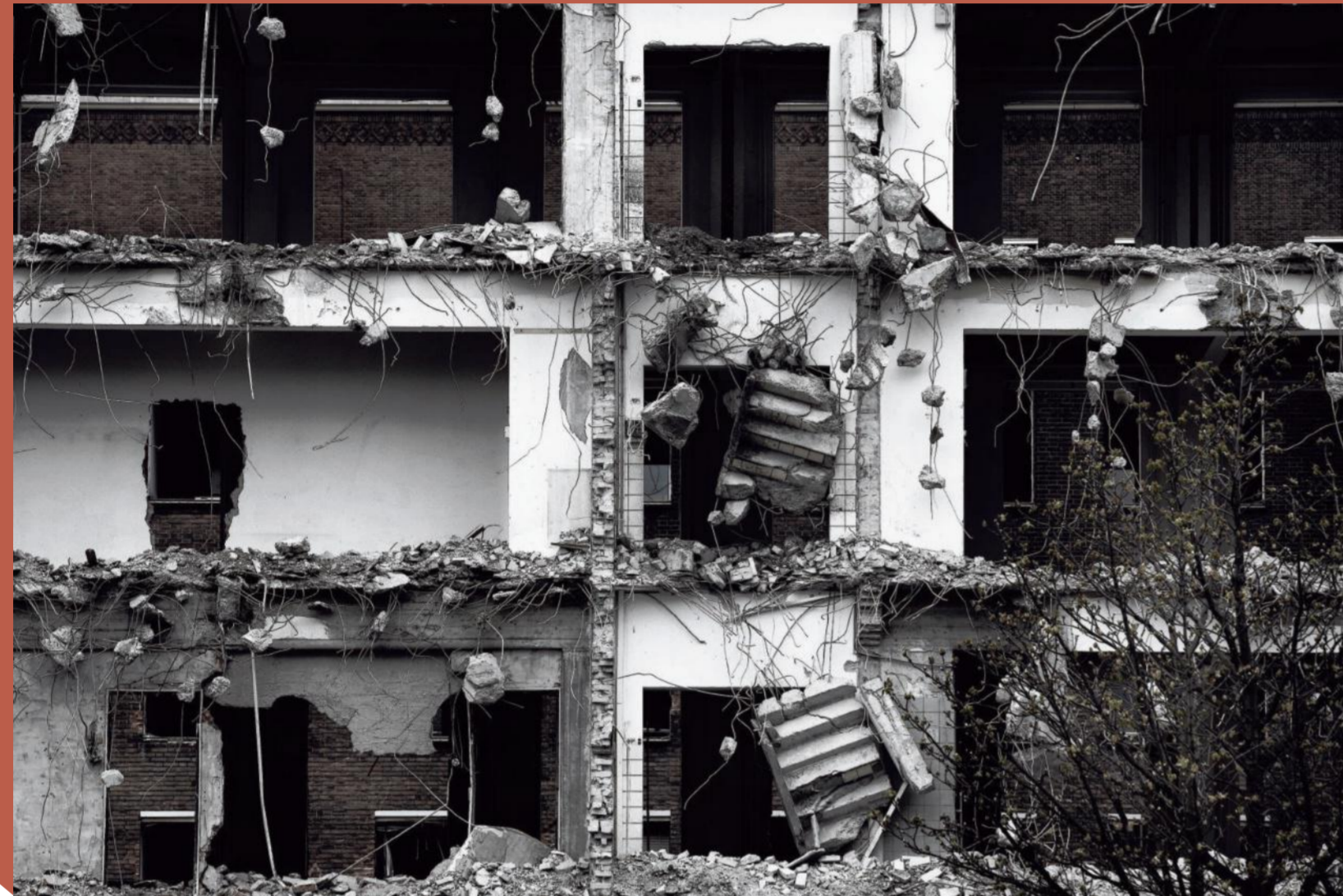
Na-oorlogse wederopbouwflat aan de Wijnhaven in Rotterdam wordt gesloopt om plaats te maken voor nieuwbouw.
