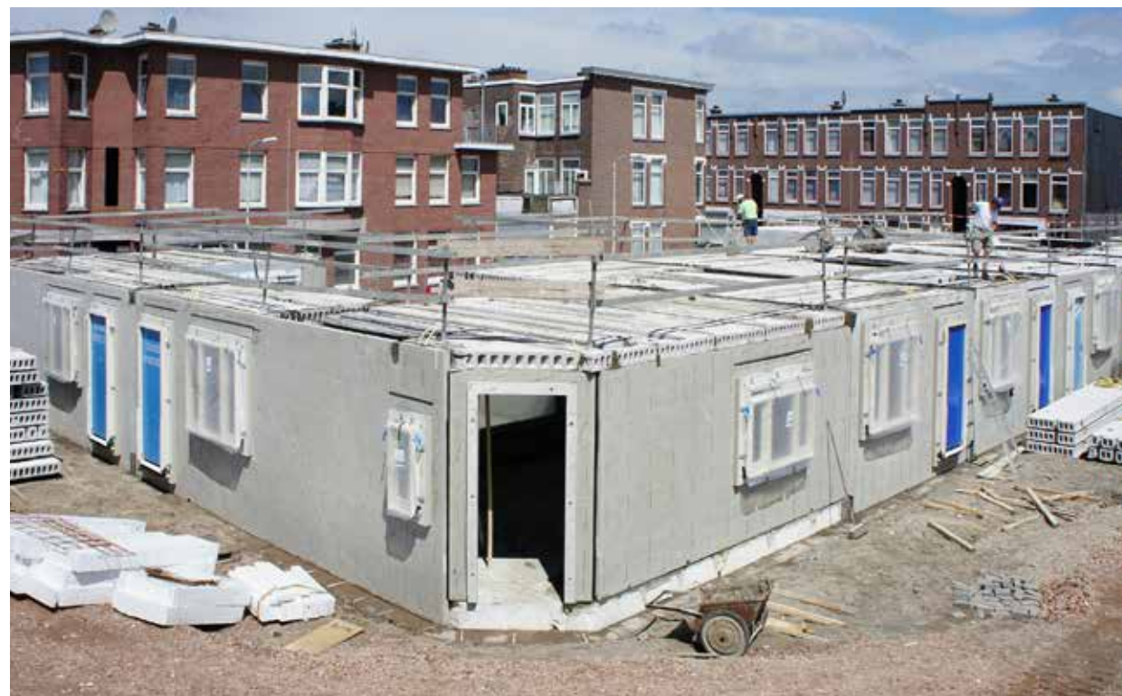
Bouwmethode van prefab beton
