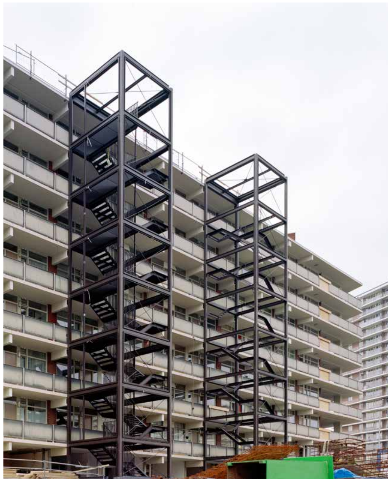
Plaatsing geprefabriceerde trappenhuizen in bewoonde staat
