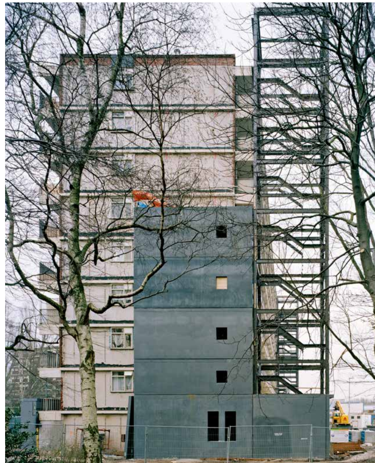
Bouw nieuwe liftschacht en noodtrappenhuis
