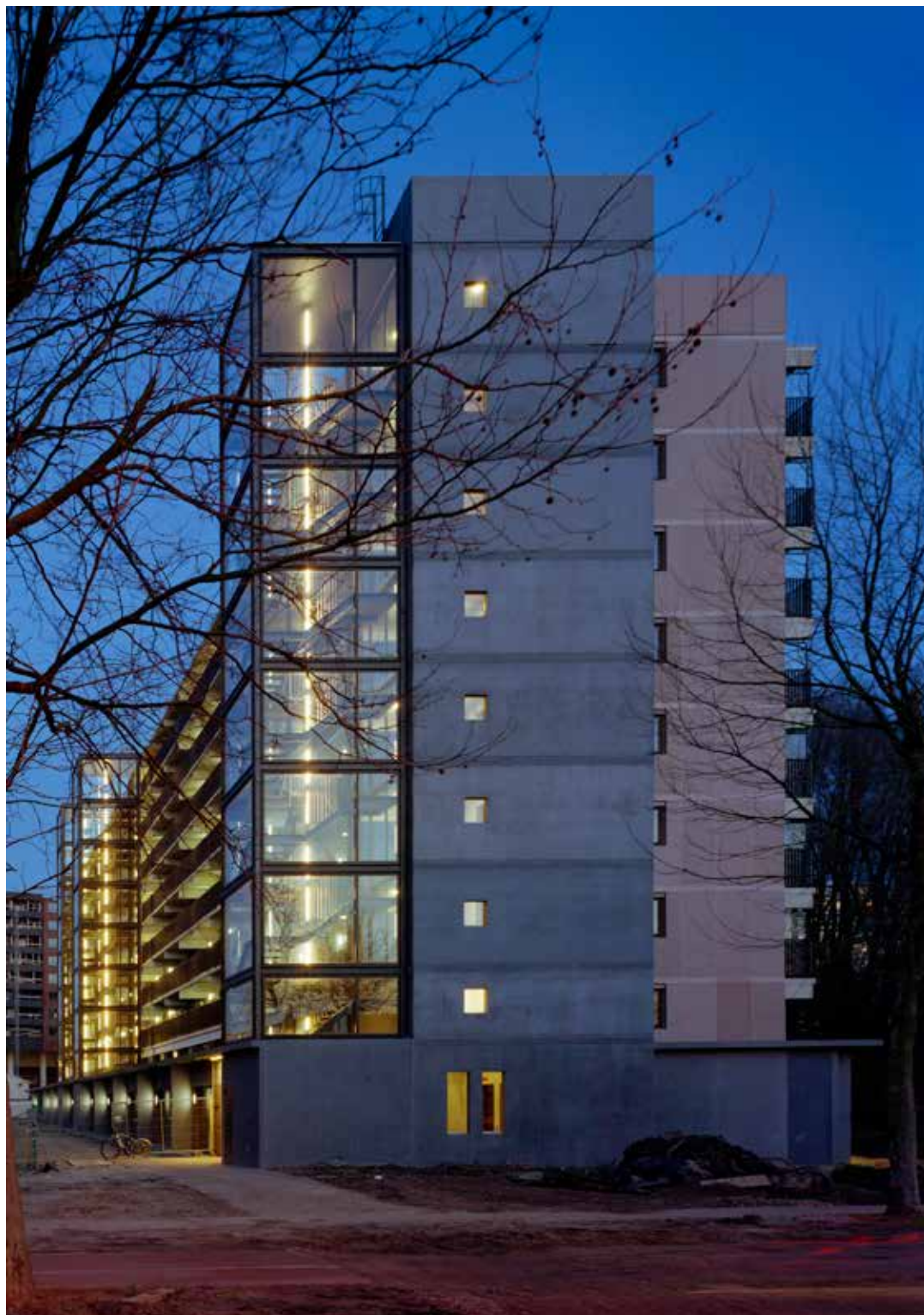
Verlichting nieuwe trappenhuizen, lifthallen en begane grond
