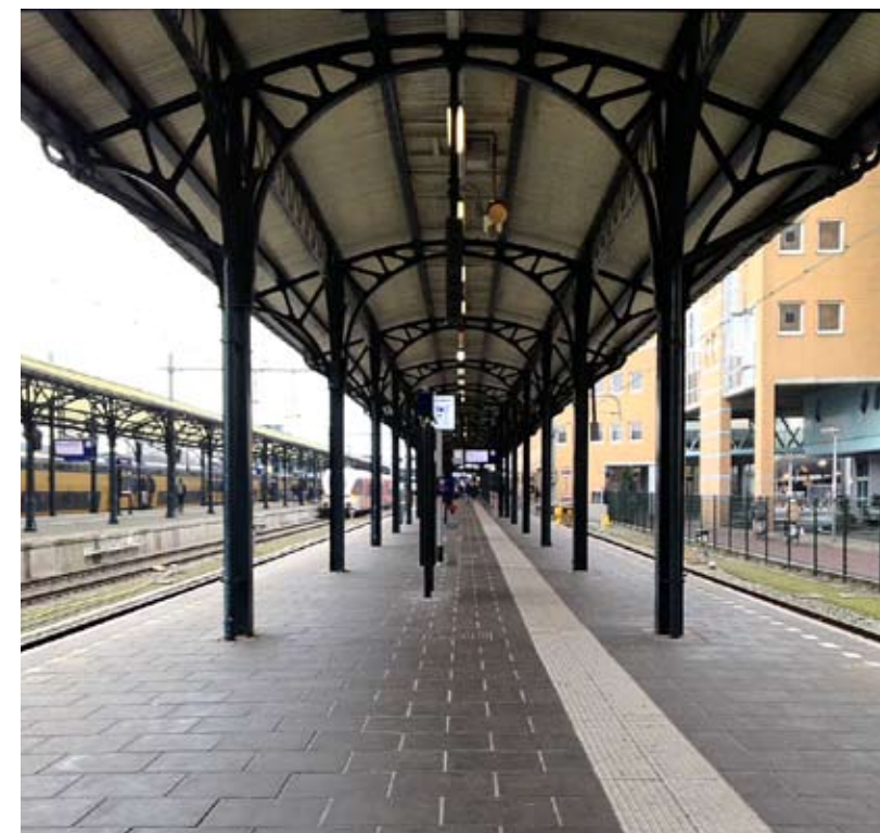
Kappen worden deel van fietsenstalling
