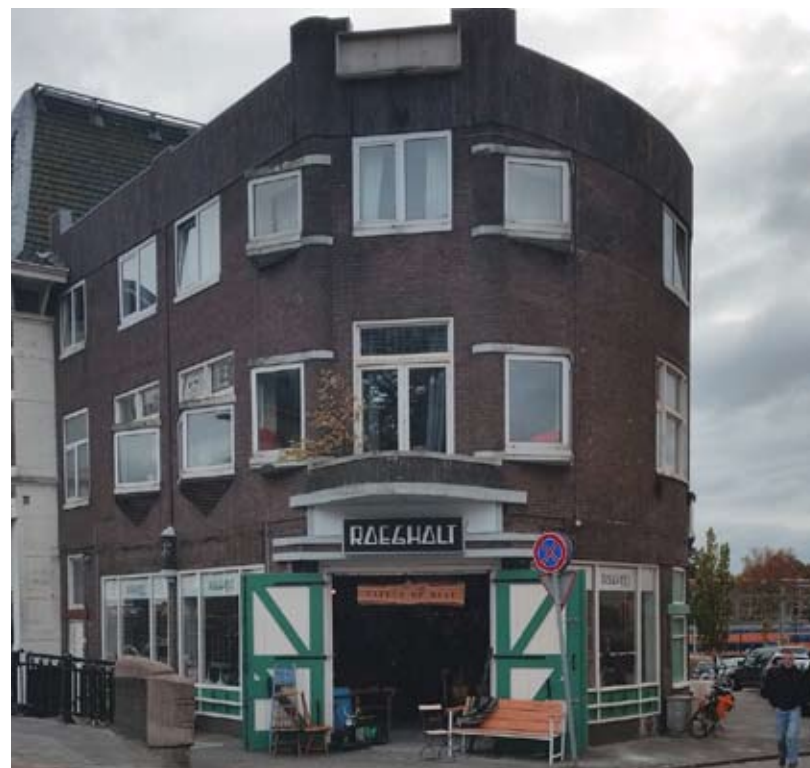
Hoekpand blokkeert zicht op Theekoepel
