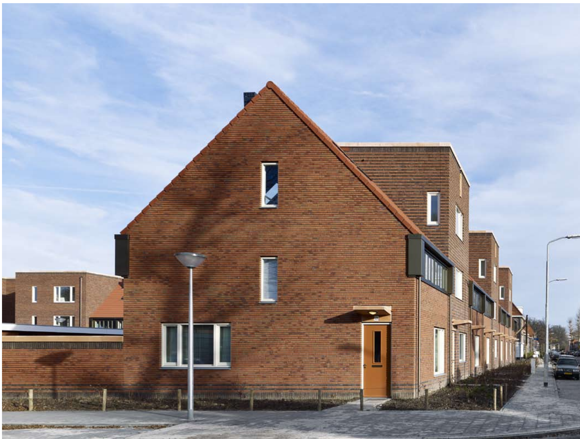
Kopgevel Halvemaanstraat - Apeldoornstraat
