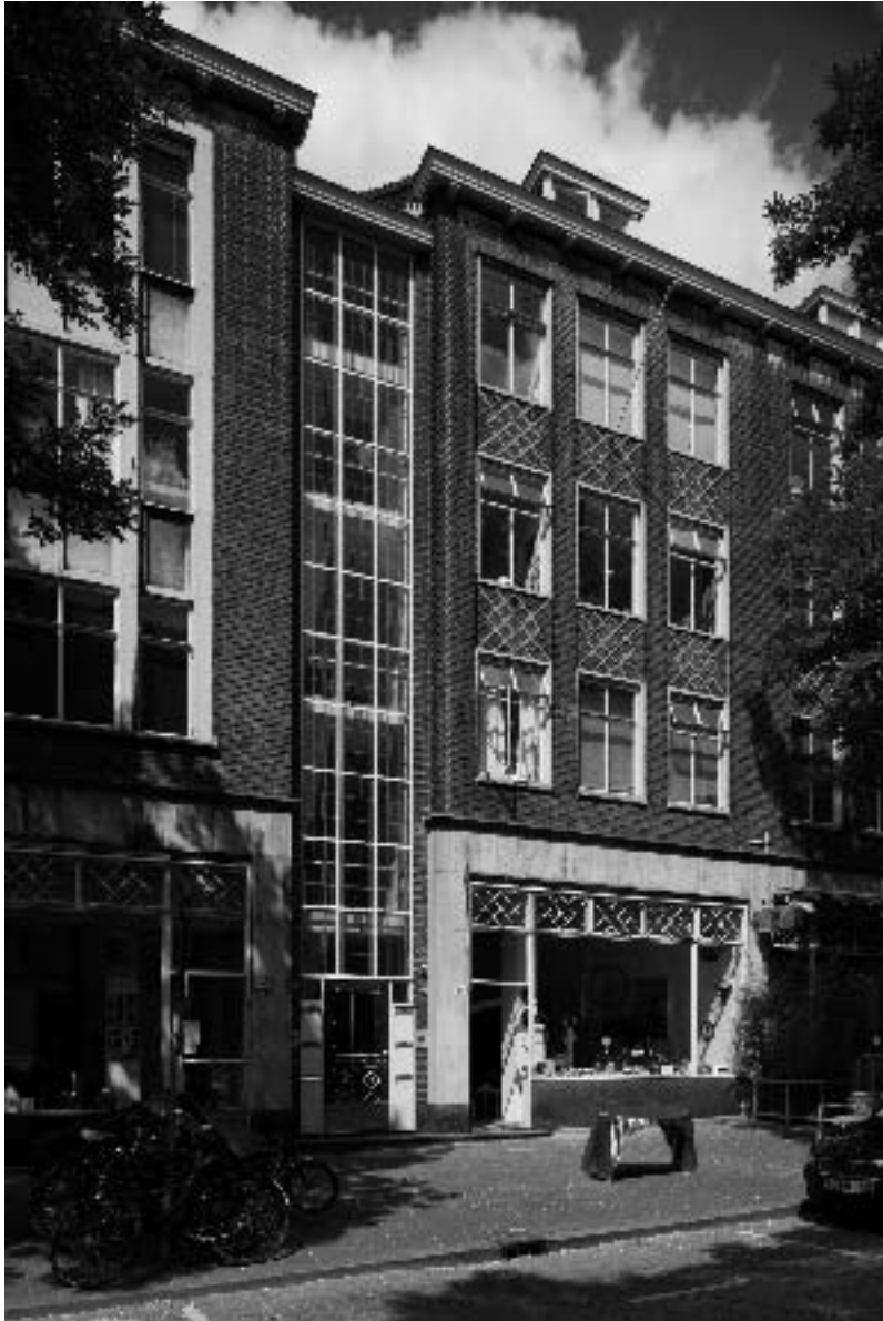
Portieketage woningen, Witte de Withstraat 1-21, M. Lockhorst en W. Overeijnder, 1949-1951
